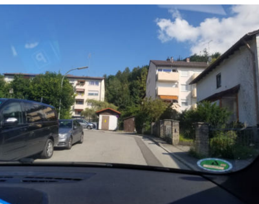
Geschosswohnungsbau in der Zinneberger Siedlung
