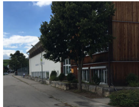
Schulturnhalle und Hallenbad
